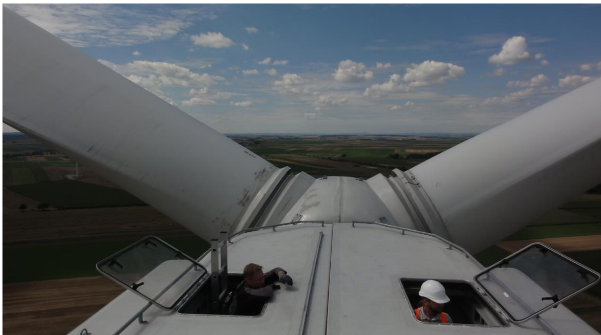
Techniker bei der Arbeit in luftiger Höhe.
