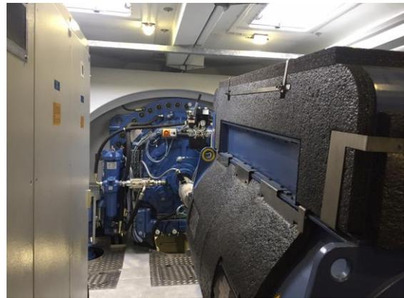
Blick ins Innere der Turbine mit Getriebe und Generator.
