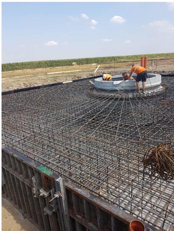
*Die Fundamente werden gemäss den Vorgaben von Vestas ausgehoben und mit Armierungseisen vernetzt.*
