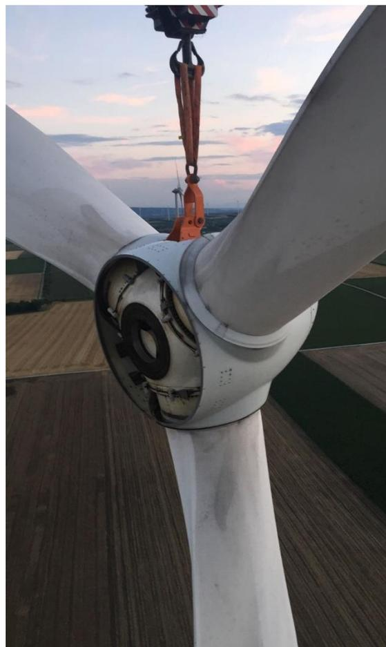
*Demontage der Vestas V80 in der Nähe von Wien. Vorsichtig werden die Rotorblätter auf den Grund hinuntergelassen, wo sie dann von der Nabe demontiert werden.*
